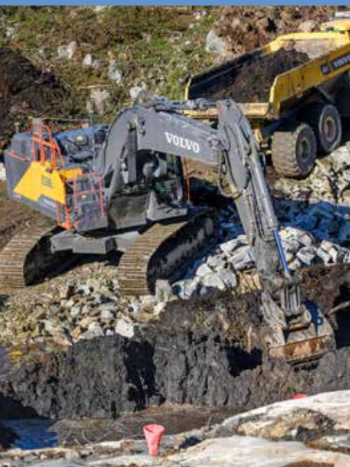
När ett surhål ska fyllas är det bra att ha tillgång till en rejäl bandgrävare som den Volvo EC550EL som Martin Eliasson kör. Dumpern är en Volvo A30G som körs av Tobias Persson.
